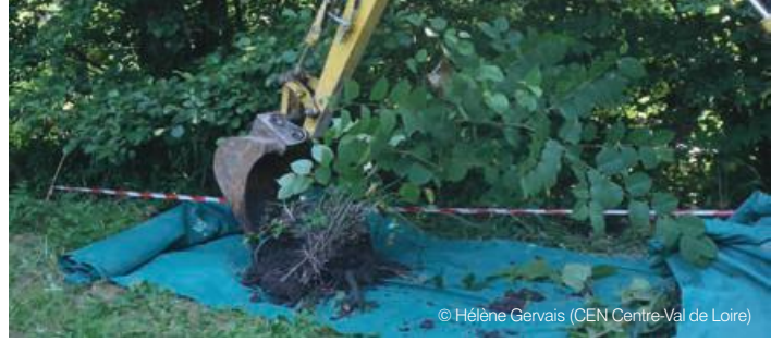
Stockage temporaire de d echets d'un chantier de gestion de renou ees
