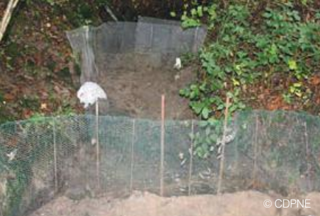
Pose de grilles de protection avant vidange
