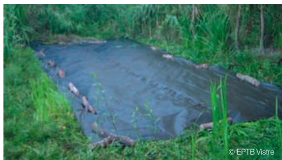
Bâchage d'une zone colonisée par les jussies
