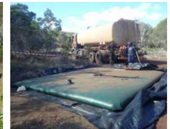
2 Alimentation d'une citerne souple (20 000 L) pour les besoins en eau d'un chantier de plantation (Pindai, 2018)
