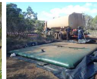
2 Alimentation d'une citerne souple (20 000 L) pour les besoins en eau d'un chantier de plantation (Pindai, 2018)
